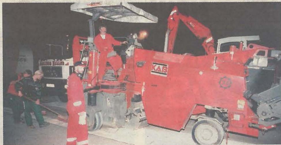
Mit Fräsen werden Betonschichten der alten Piste abgetragen, um klaglose Übergänge zur neuen Asphalt-schicht herstellen zu können.
